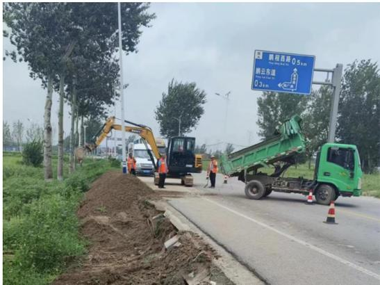
图：对廊涿线涉水路段边沟进行水毁修复
