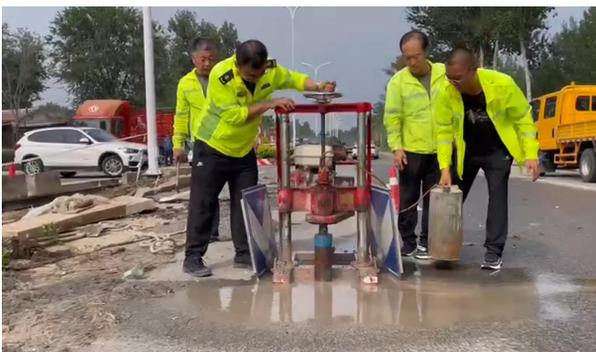
图：对廊霸线涉水路段基层进行钻孔检测
